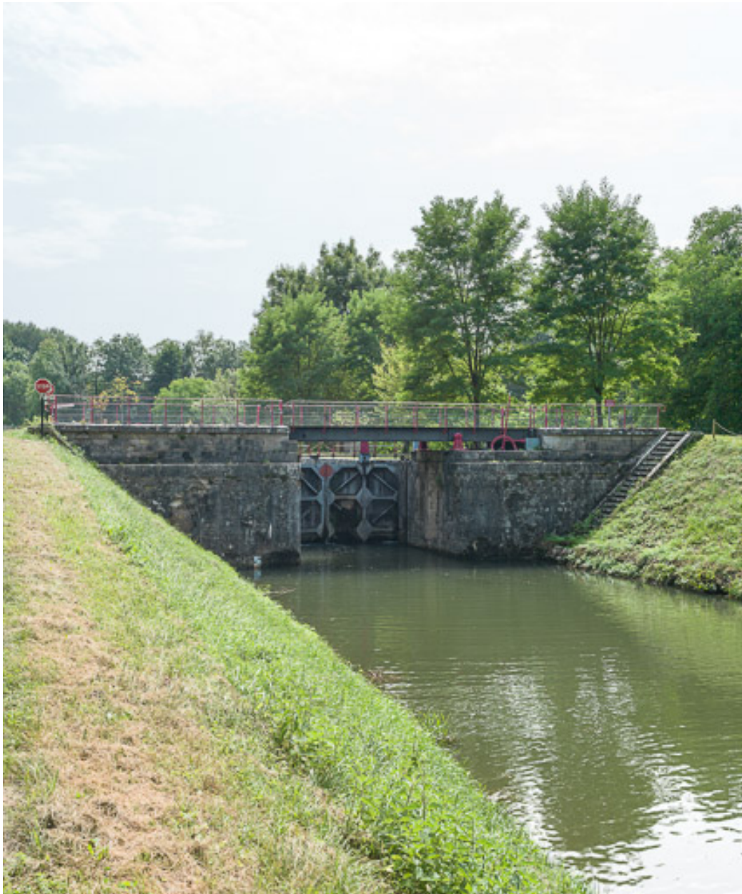
Vue du pont.
