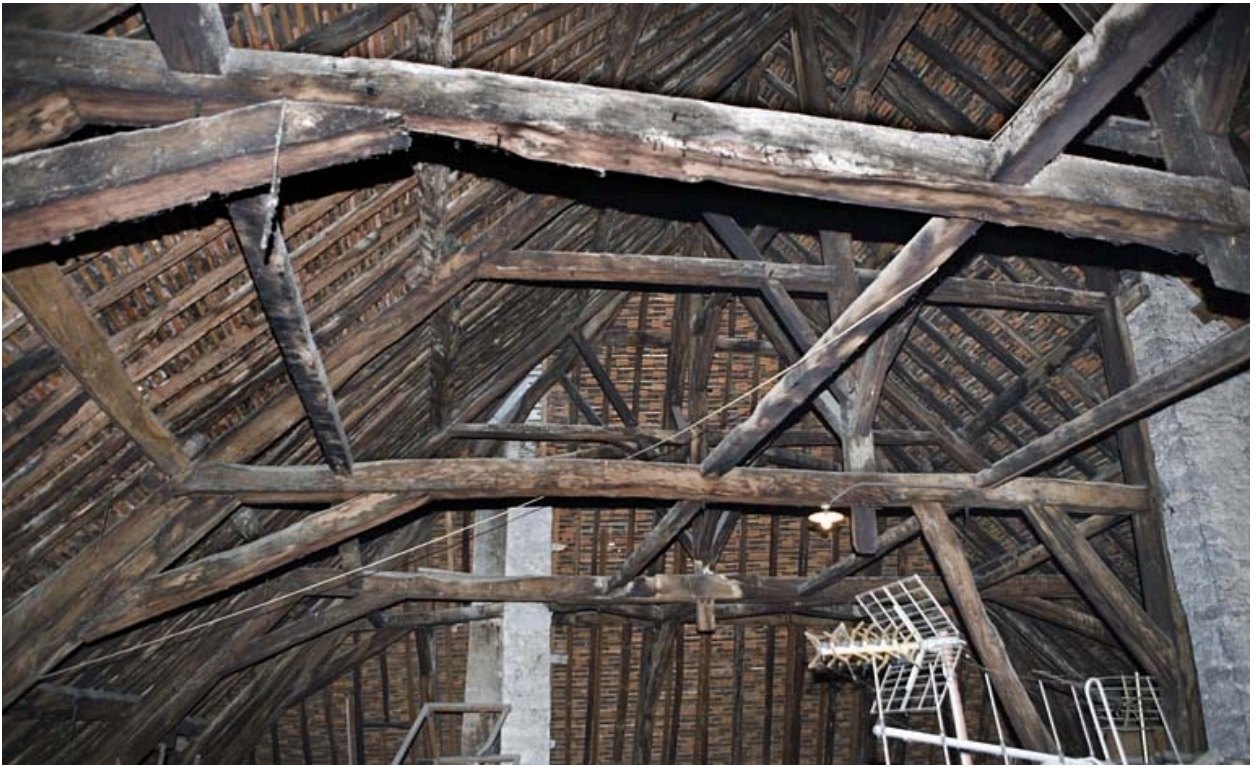
Intérieur, comble : vue de la charpente depuis l'entrée.
