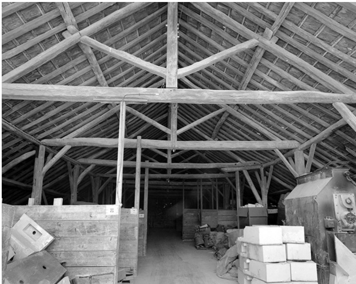
Charpente du hangar à terre (25).
