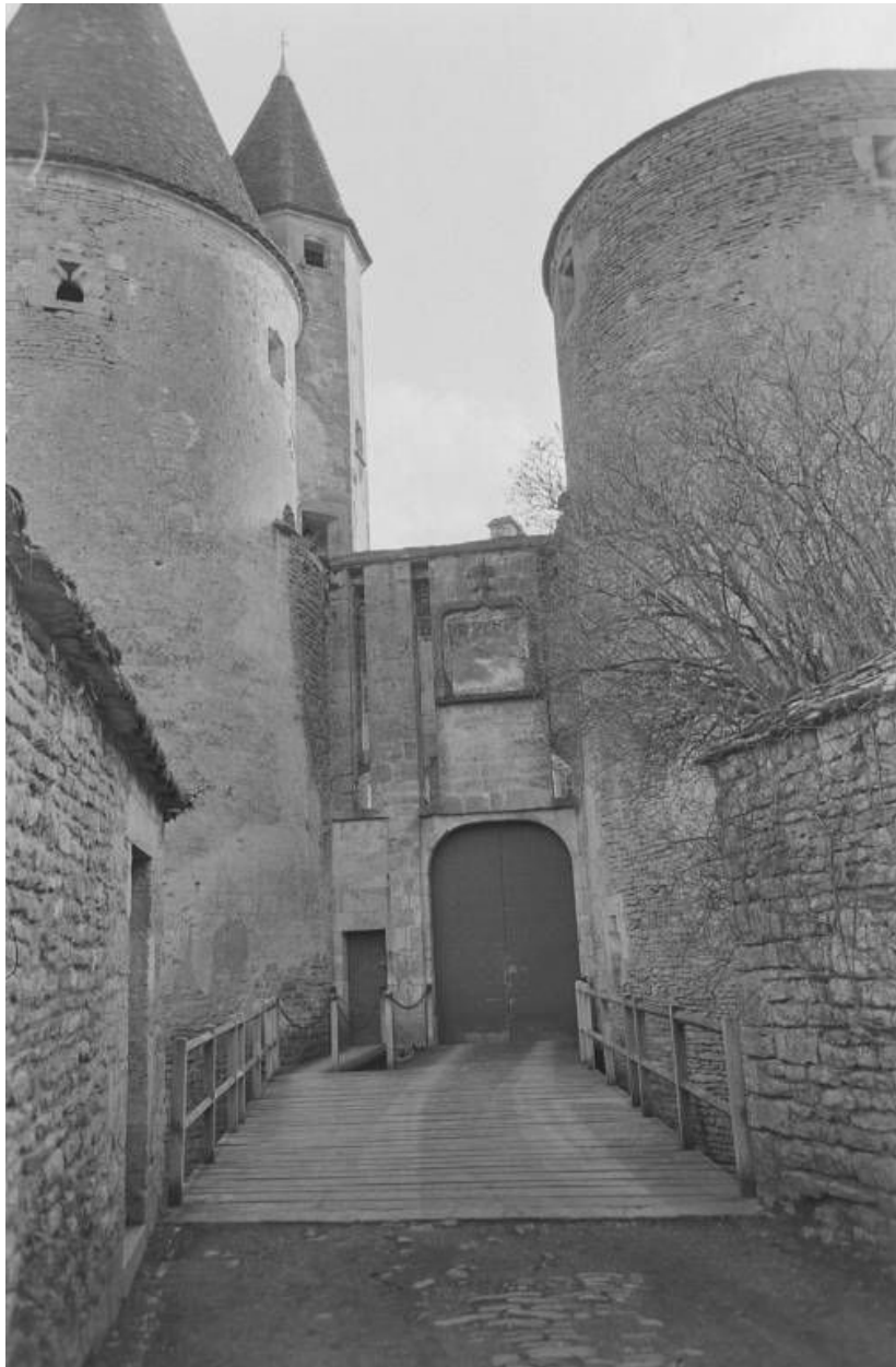
Le dispositif d'entrée vu de l'extérieur (photo prise en 1969).
