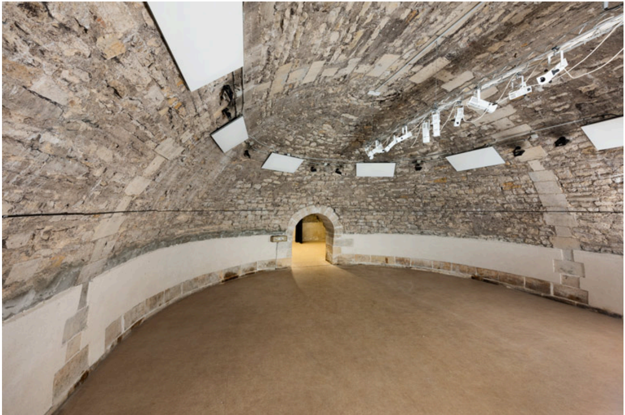
Etage de soubassement, partie centrale : grande cave, vue de l'entrée.
