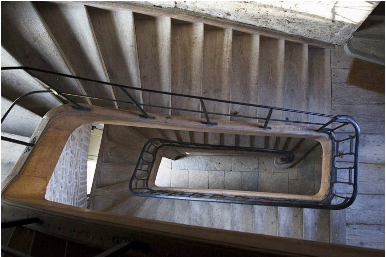
Intérieur : vue de l'escalier secondaire situé dans l'aile droite : en plongée.
