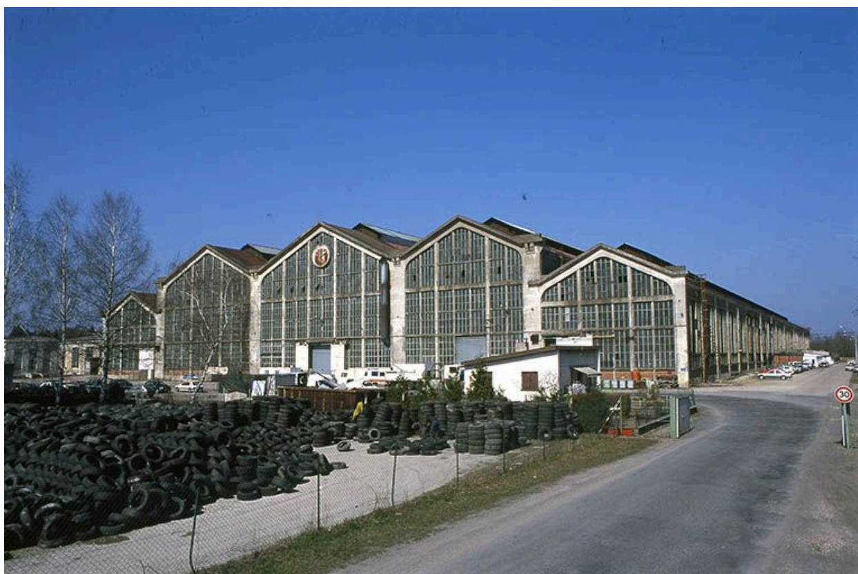
Elévation sud-ouest de la grande halle.
