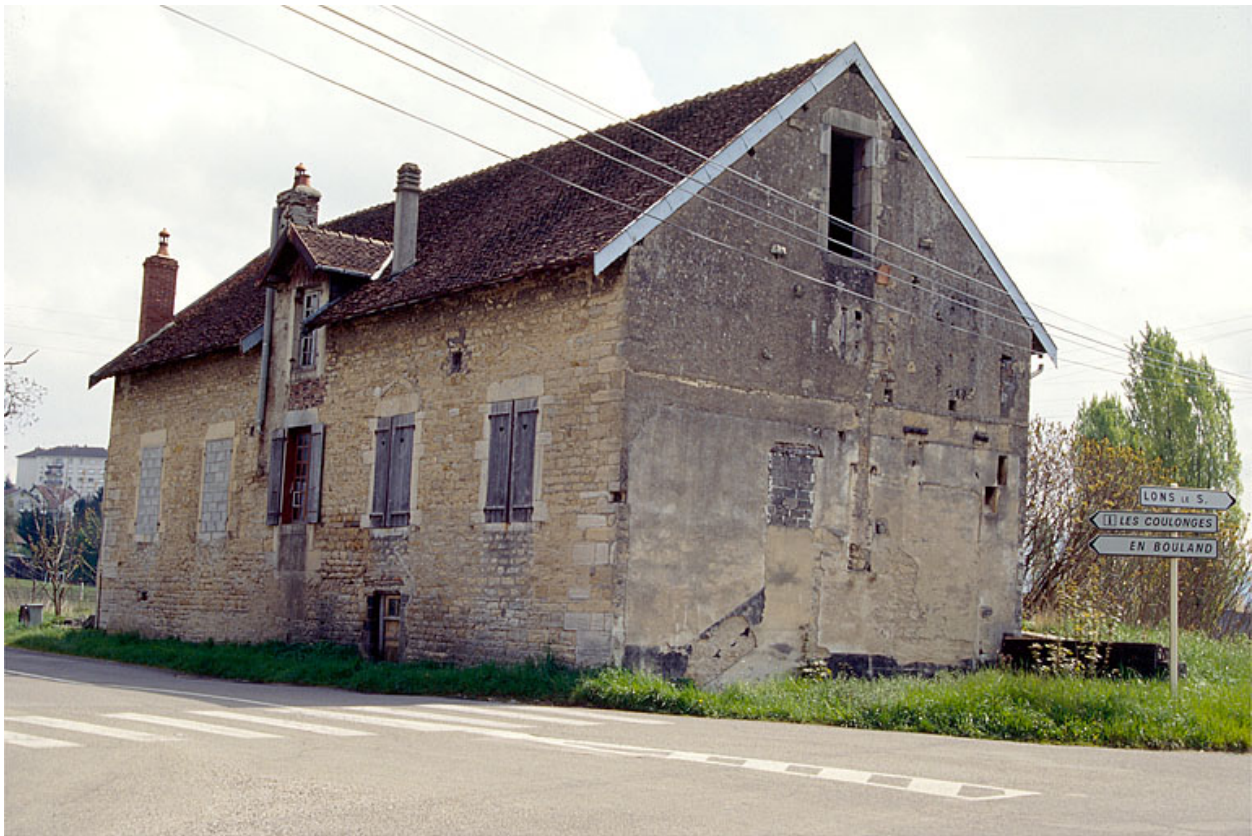
Bâtiment d'une turbine.
