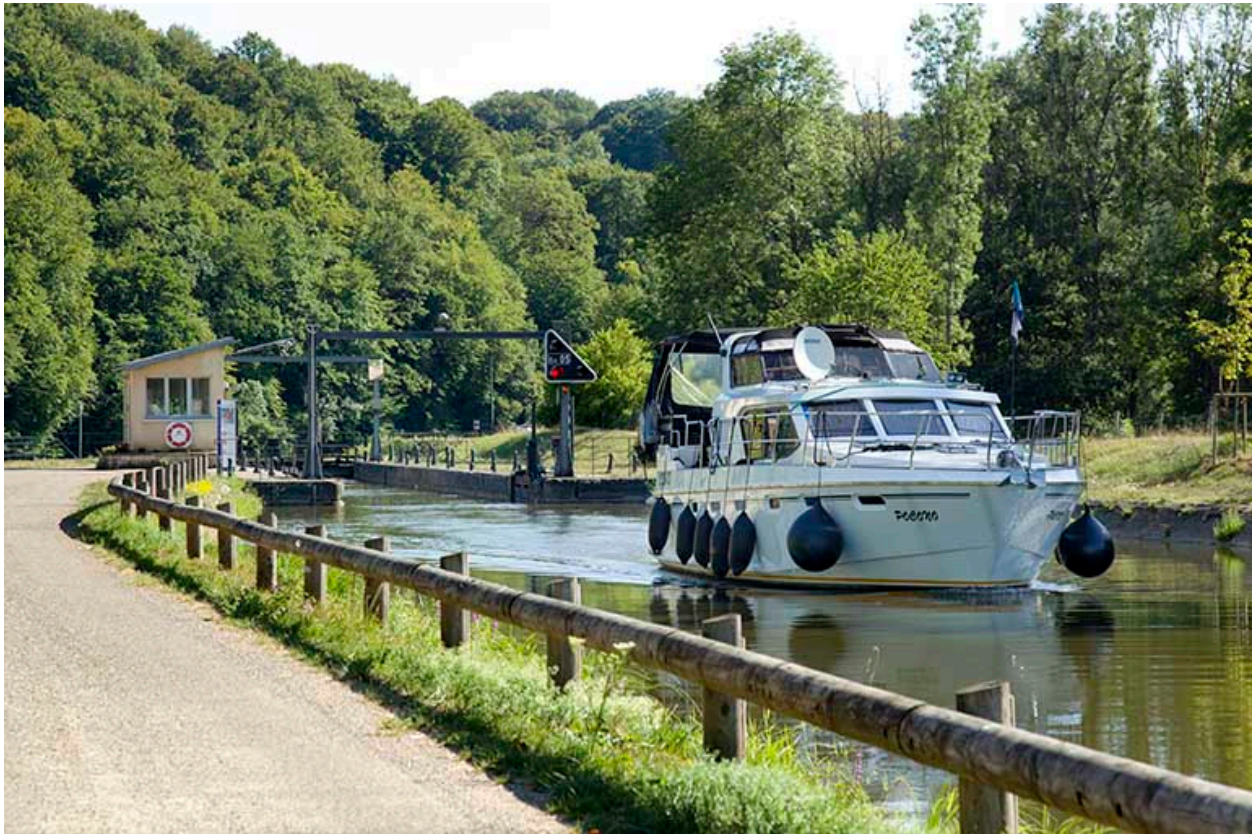
L'écluse de Port-sur-Saône.
