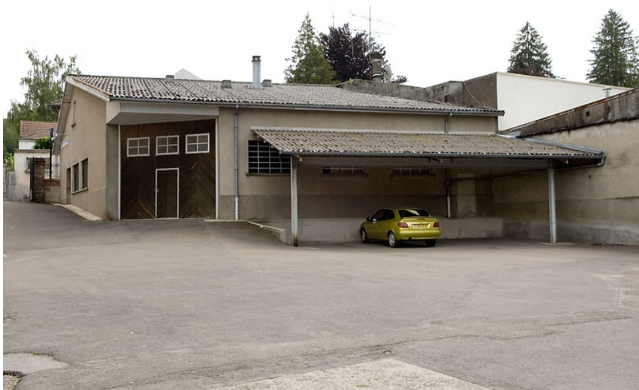
Atelier de fabrication (?). Vue depuis la cour.
