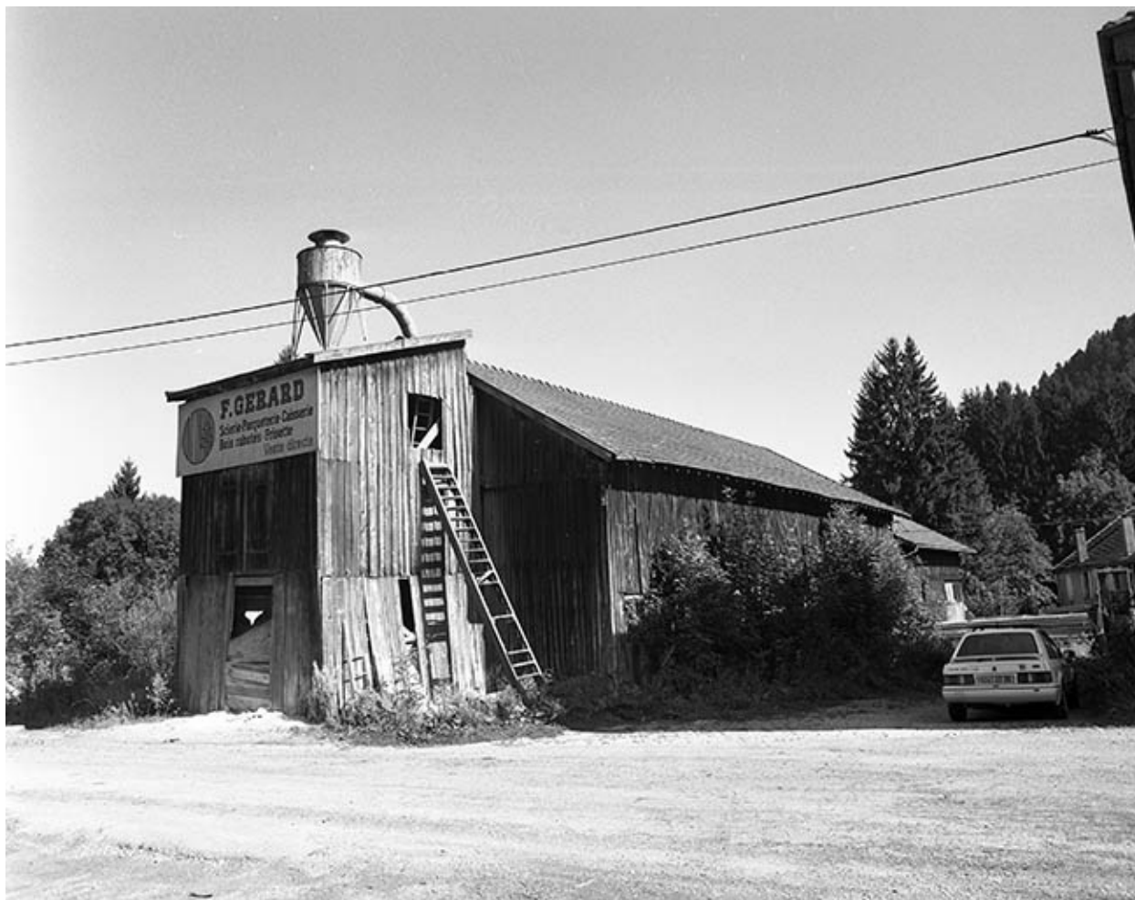
La parqueterie (désaffectée).
