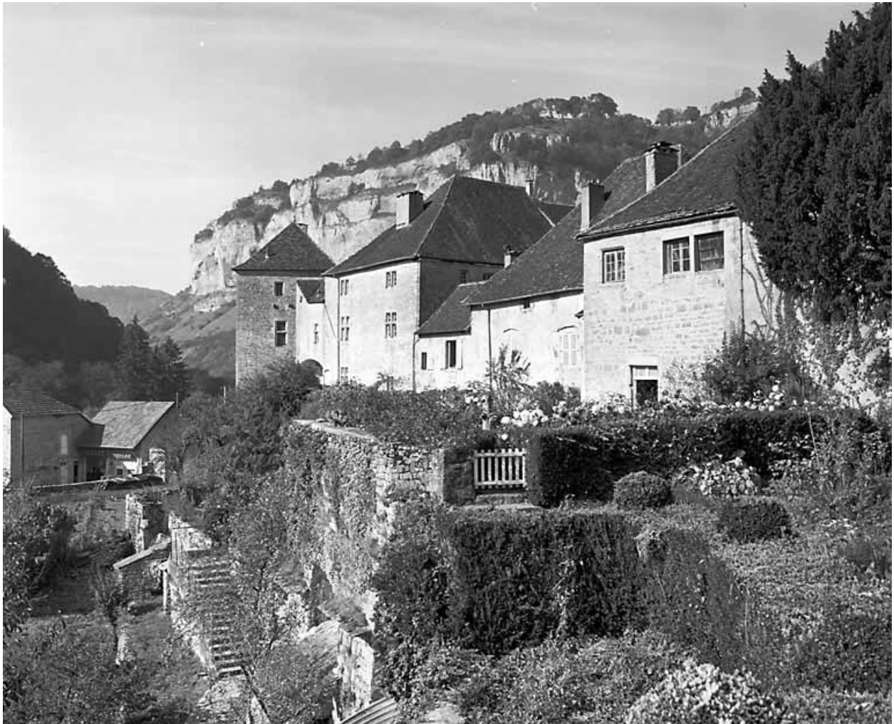
Vue générale des faces sud des bâtiments de l'abbaye.
