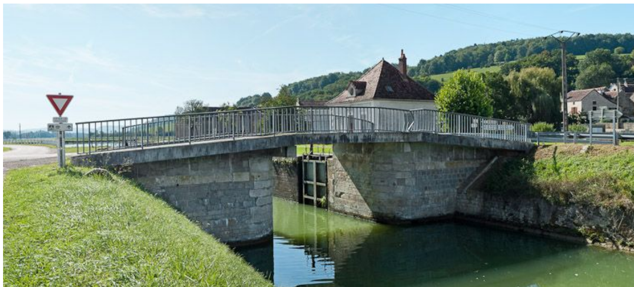
Vue du pont depuis l'aval.
