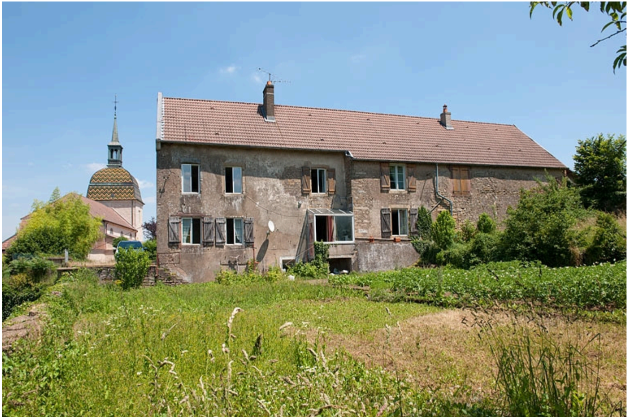
Vue générale de la façade postérieure.
