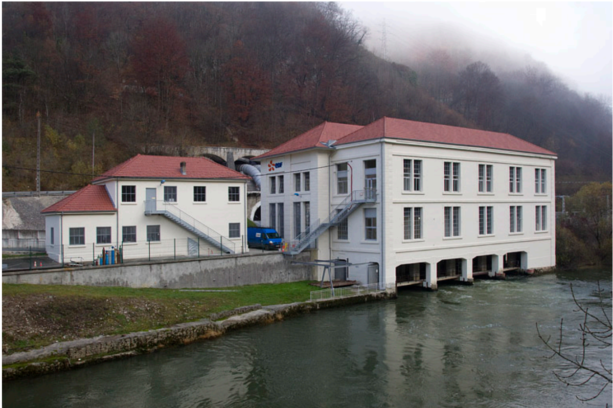
Atelier de réparation et centrale depuis le sud-ouest (aval rive gauche).
