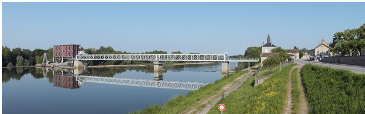
Vue d'ensemble du barrage.
