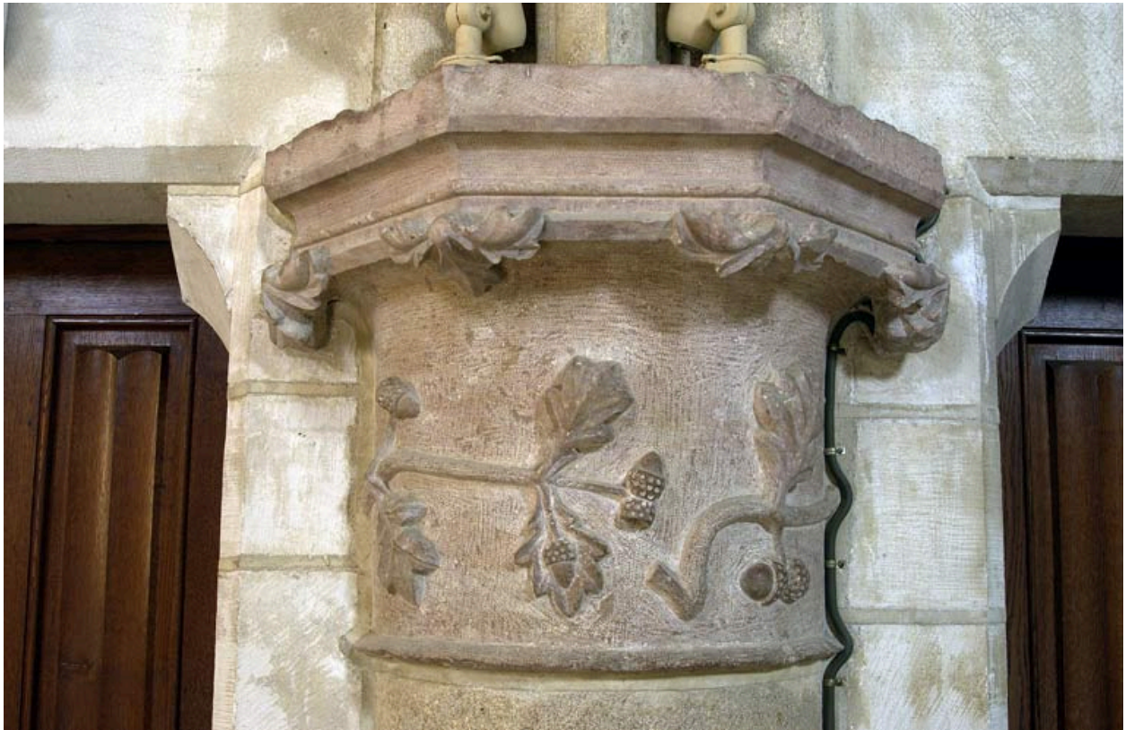
Bâtiment du réfectoire : chapiteaux feuillagés (13e siècle).
