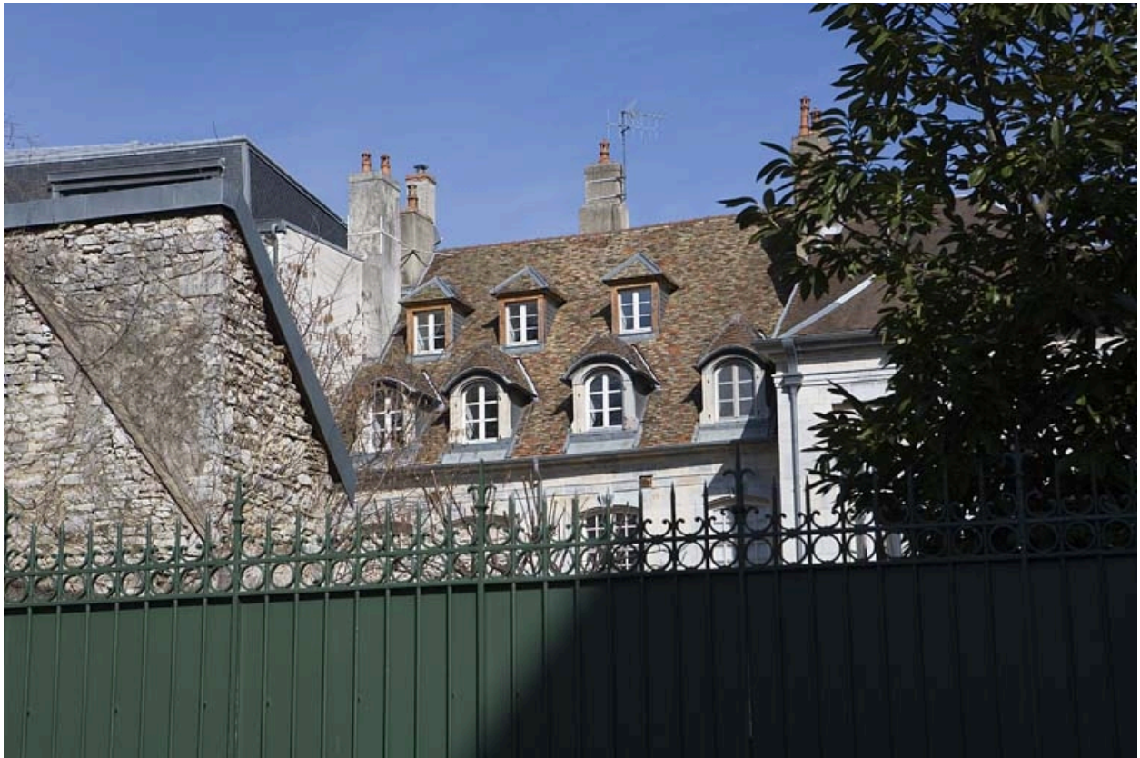
Façade postérieure depuis la place du Théâtre.
