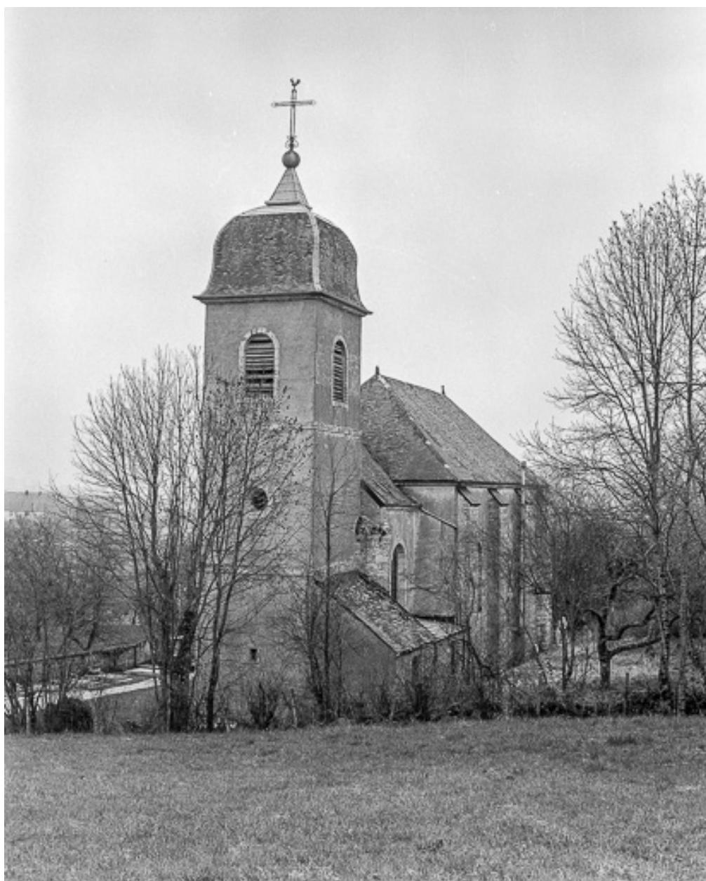
Extérieur : façades postérieure et latérale gauche.
