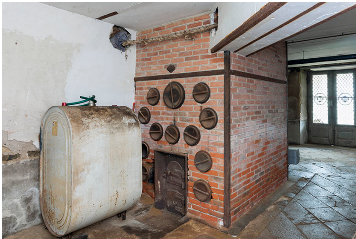
L'ancien chauffage centrale du château.
