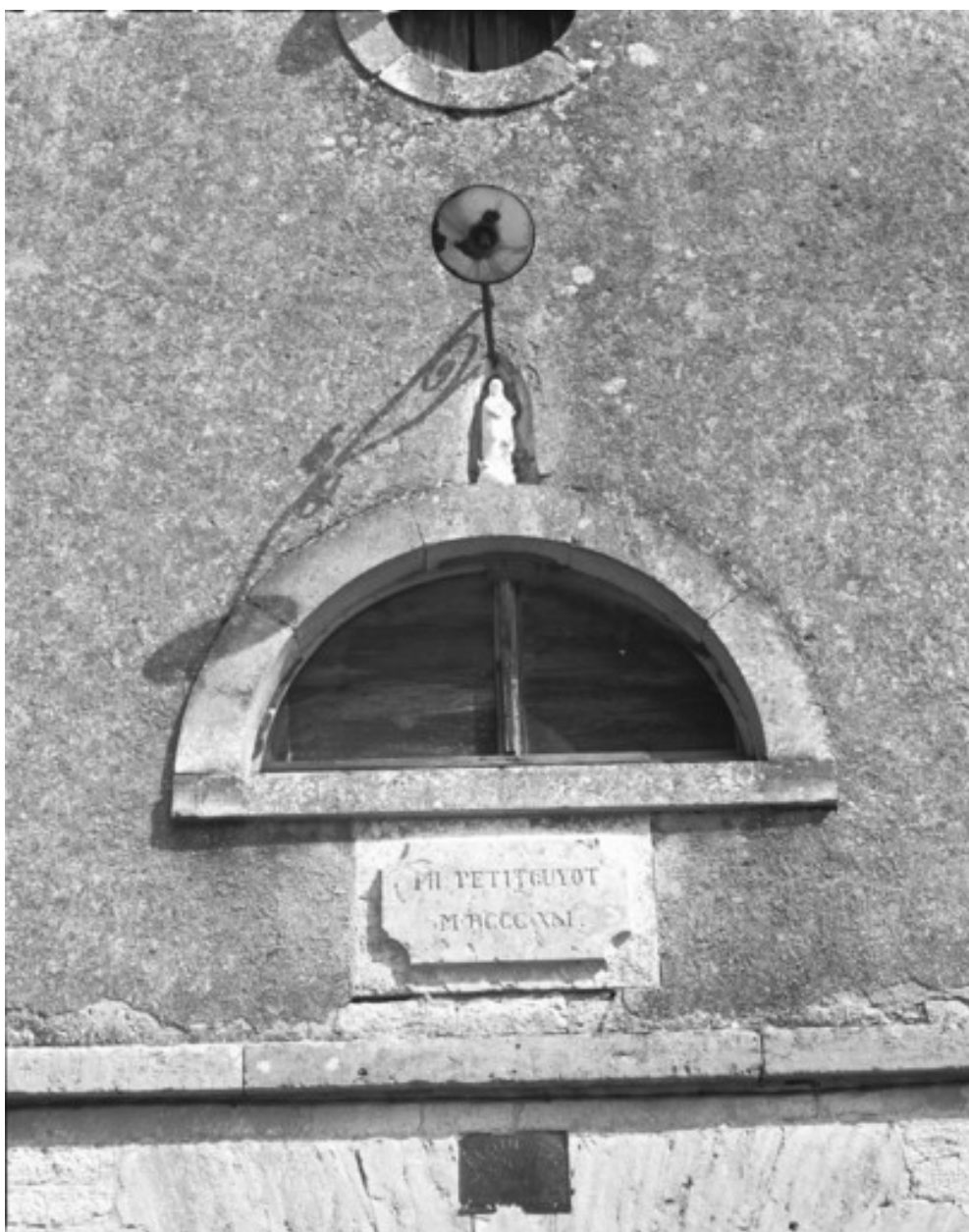
Détail du pignon du haut fourneau en 1989.
