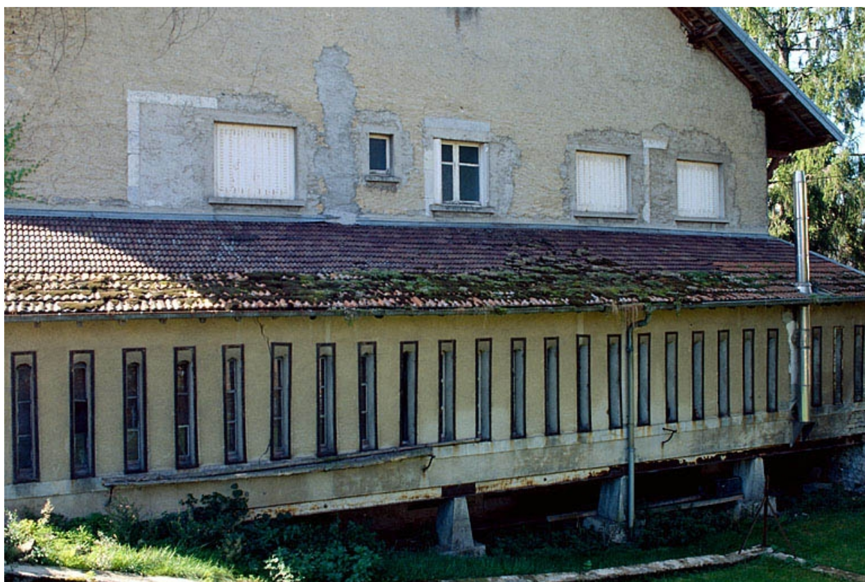
Ancienne chambre à lait en façade postérieure.
