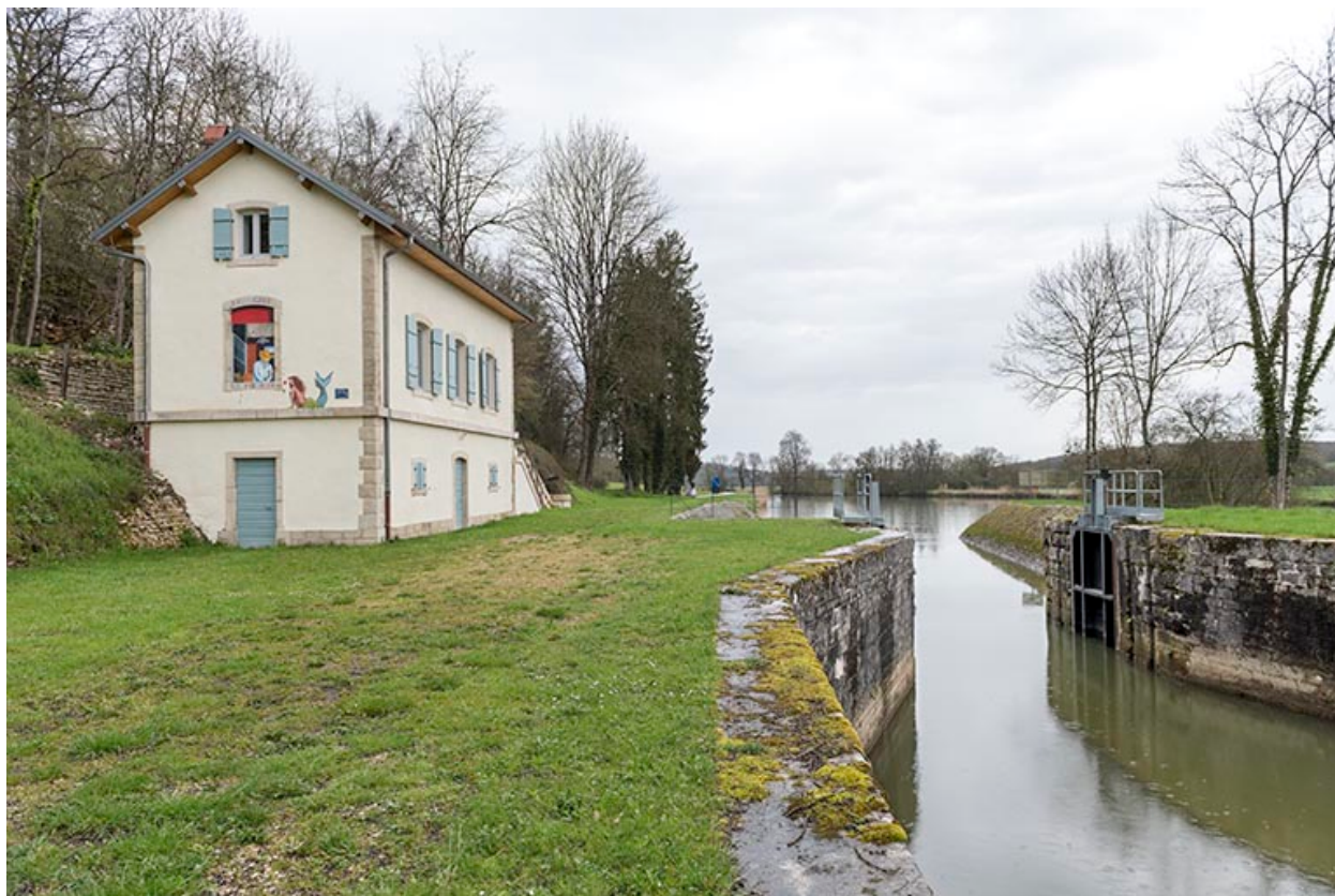
Vue depuis l'aval du site d'écluse.
