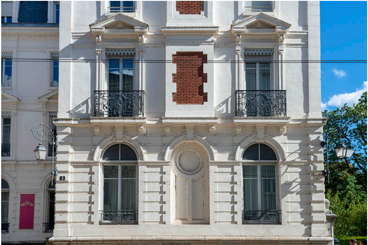
Façade sur l'avenue Carnot, avant-corps de droite, détail du rez-de-chaussée surélevé.
