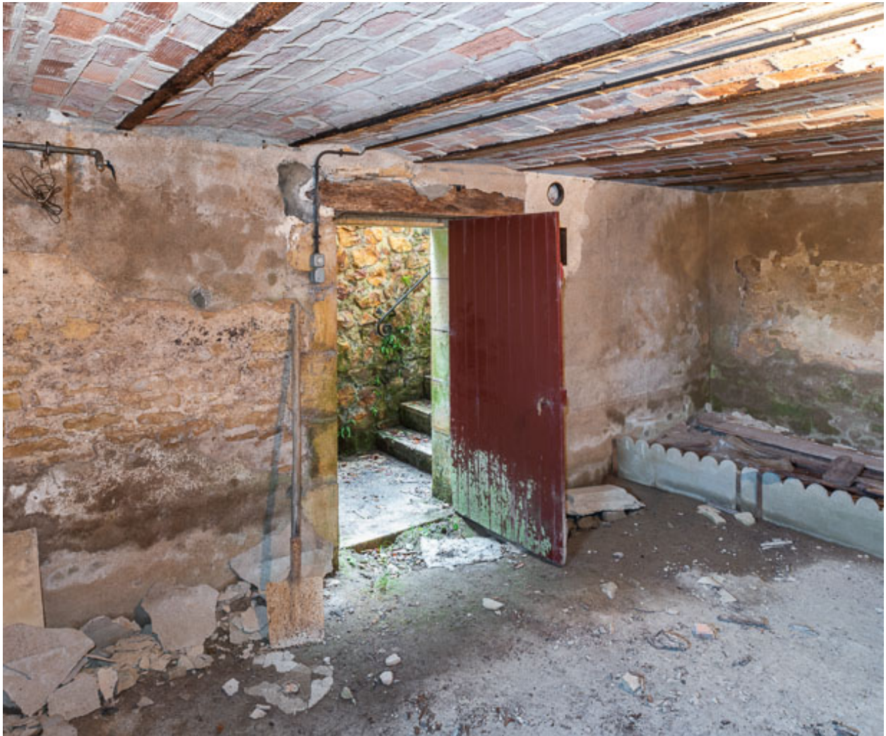
Vue intérieure de la cave.
