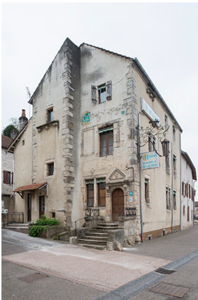
Vue générale depuis la rue Jean Bogé.
