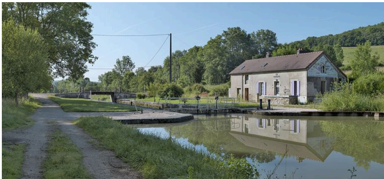
Site d'écluse vu d'amont.
