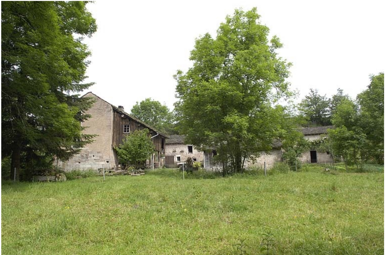
Vue d'ensemble depuis le sud.
