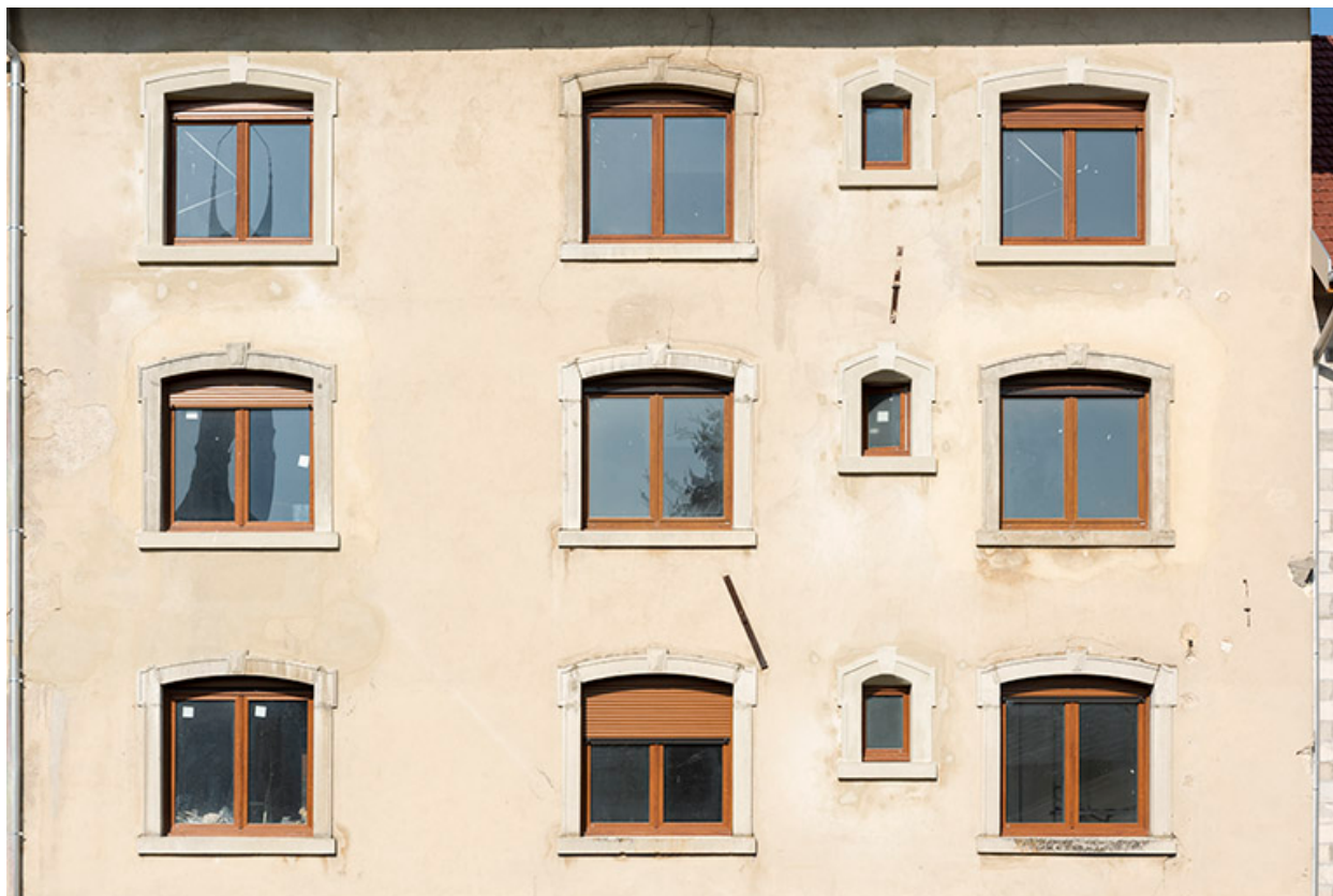
Façade postérieure : fenêtres.
