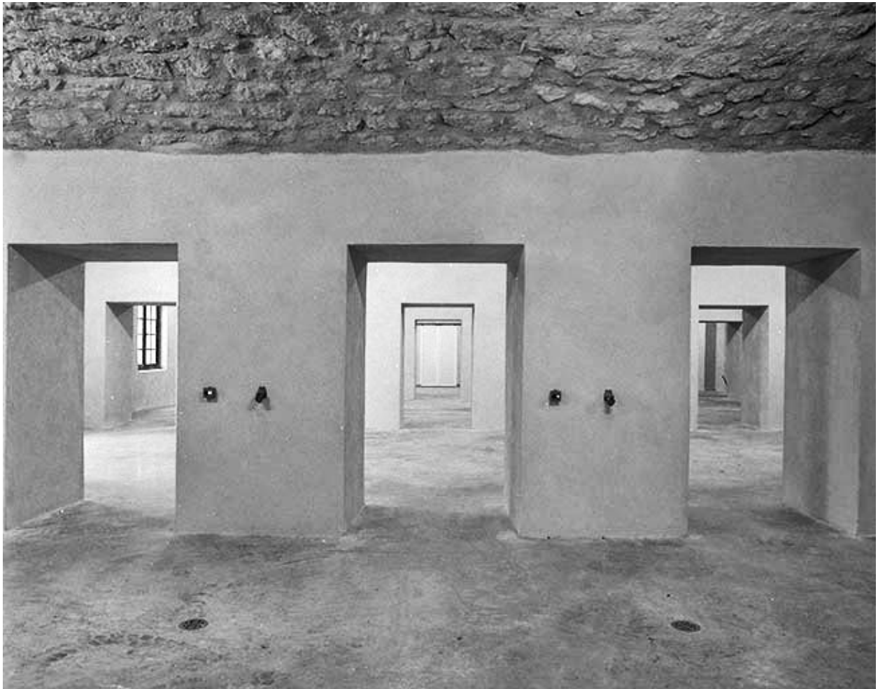
Bâtiment Quitry, pièces successives couvertes de voûtes en berceau segmentaire.
