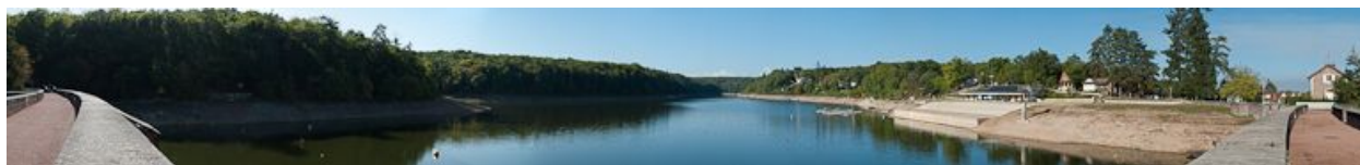
Vue d'ensemble du réservoir.
