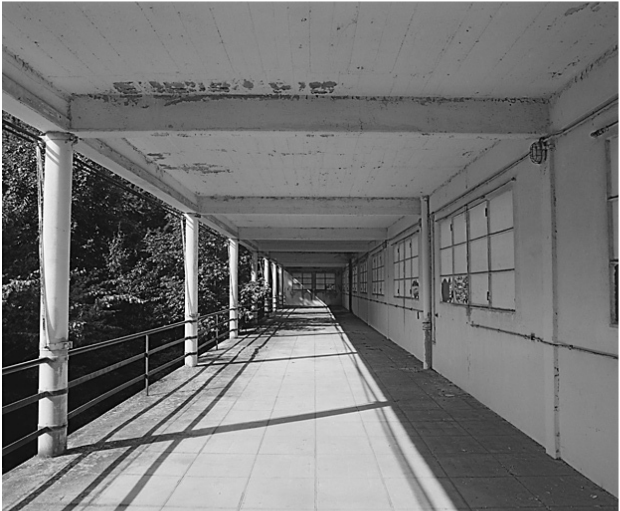
Galerie de cure ouest, façade sud-est.
