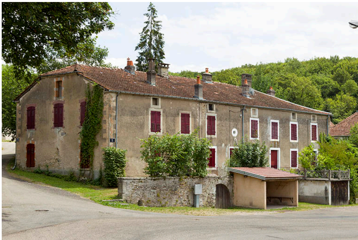
Logements d'ouvriers, place Dieu.
