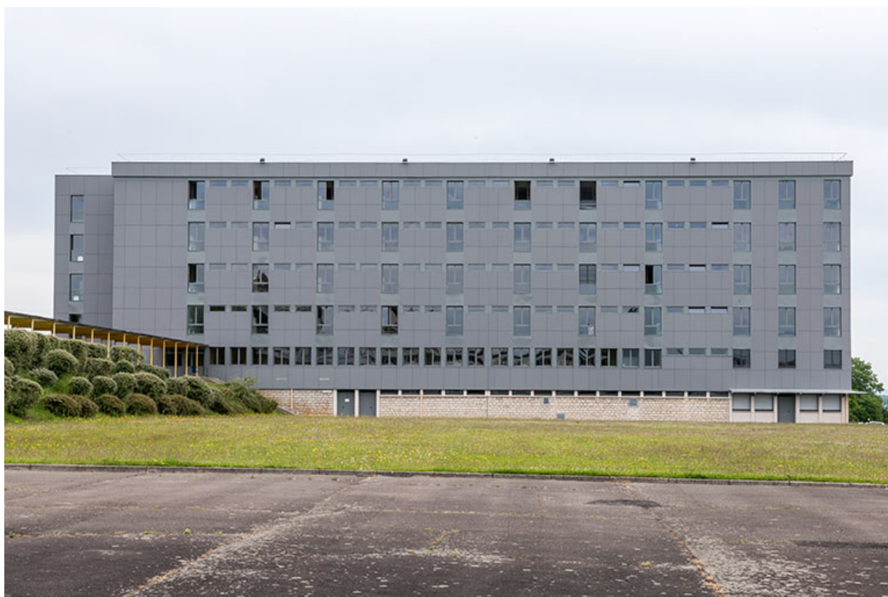
Internat : façade antérieure.
