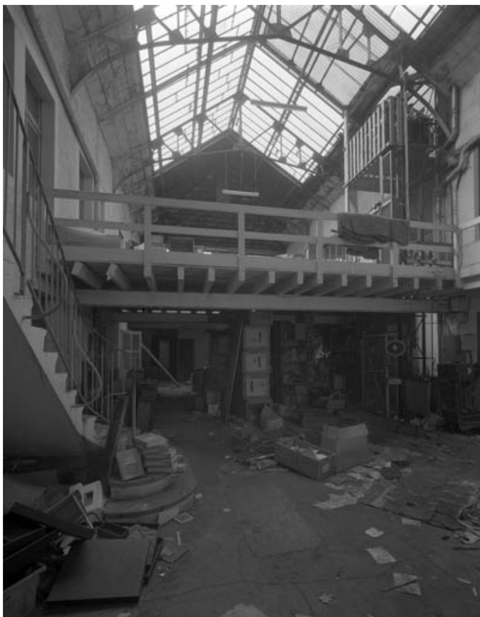
Rez-de-chaussée de la cour couverte.
