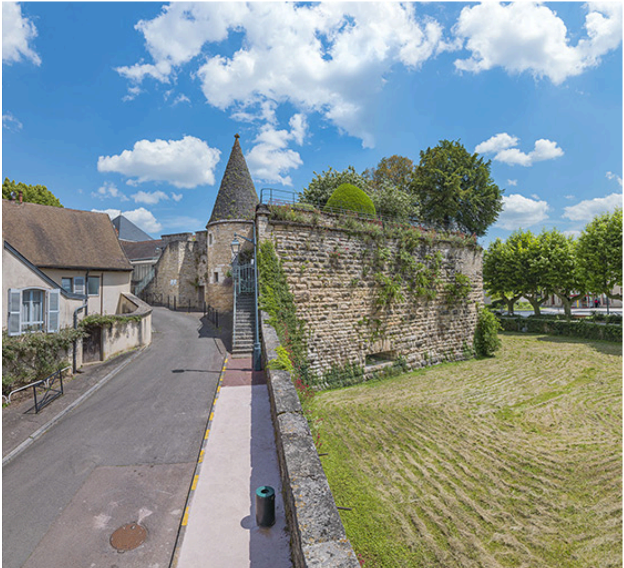
La tour, vue depuis celle des Bouchers.
