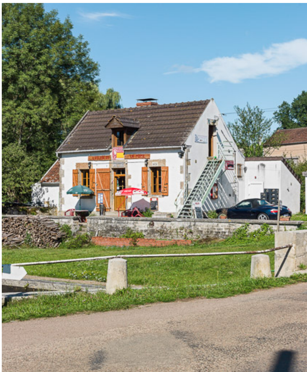
Vue de la maison éclusière.
