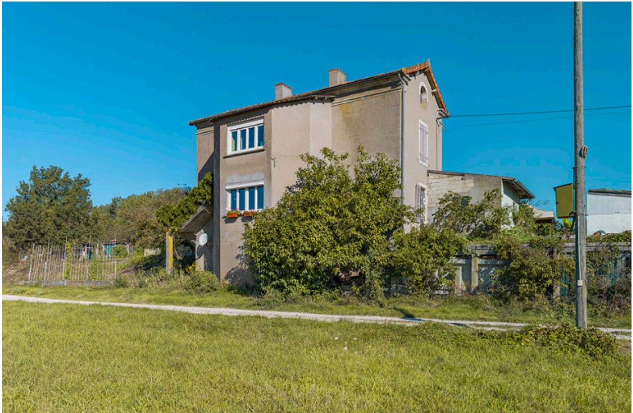
Façade arrière avec l'ajout d'un avant-corps central.
