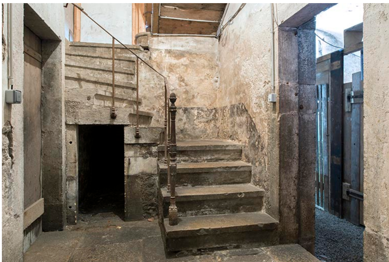
Chaudronnerie : escalier, au sous-sol.
