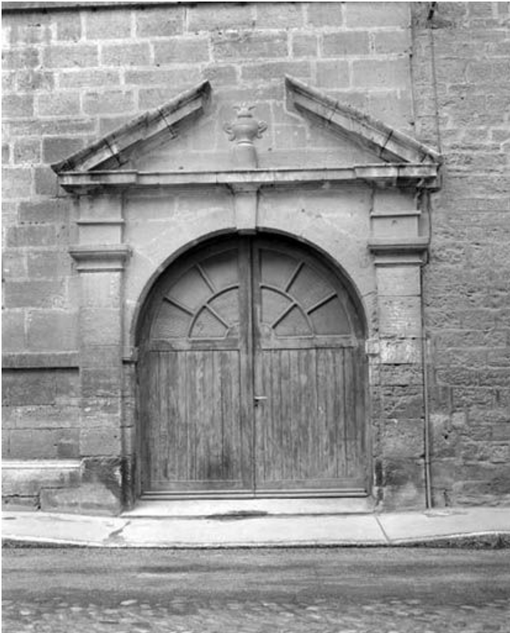
Façade antérieure : porte cochère.
