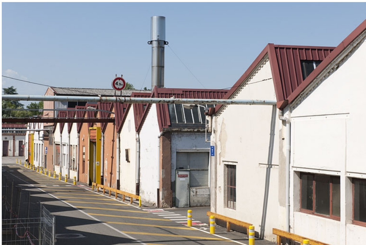
Pignons des ateliers ouest.
