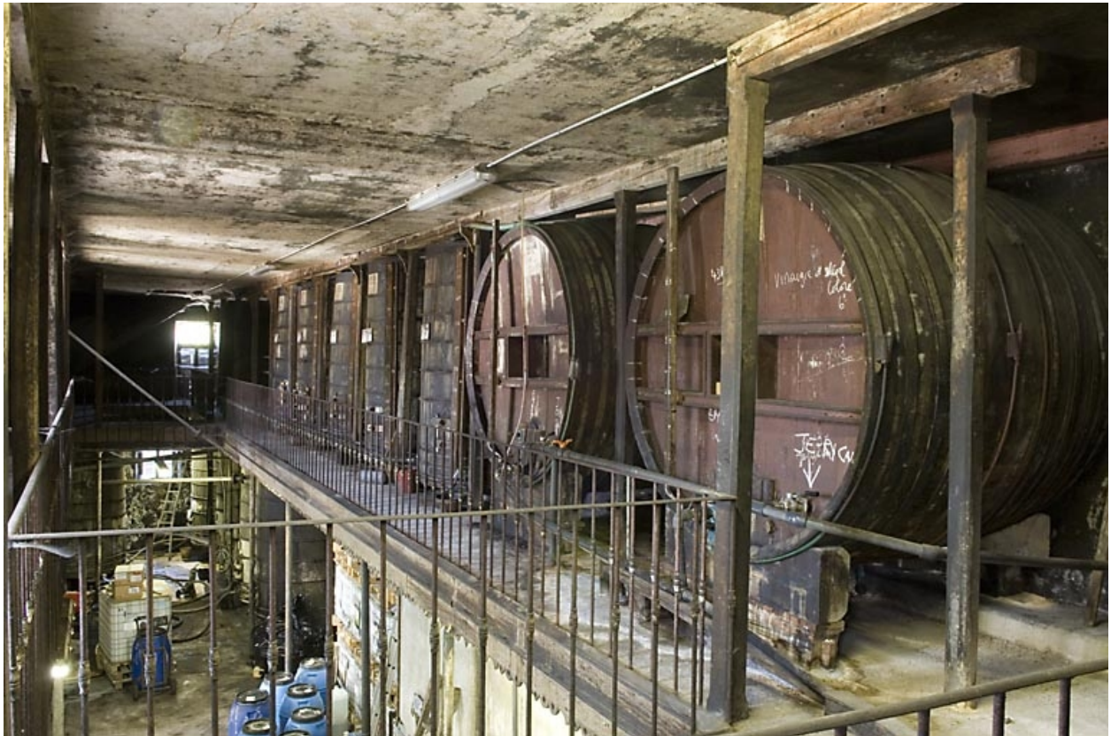
Etage de la cuverie (partie est).
