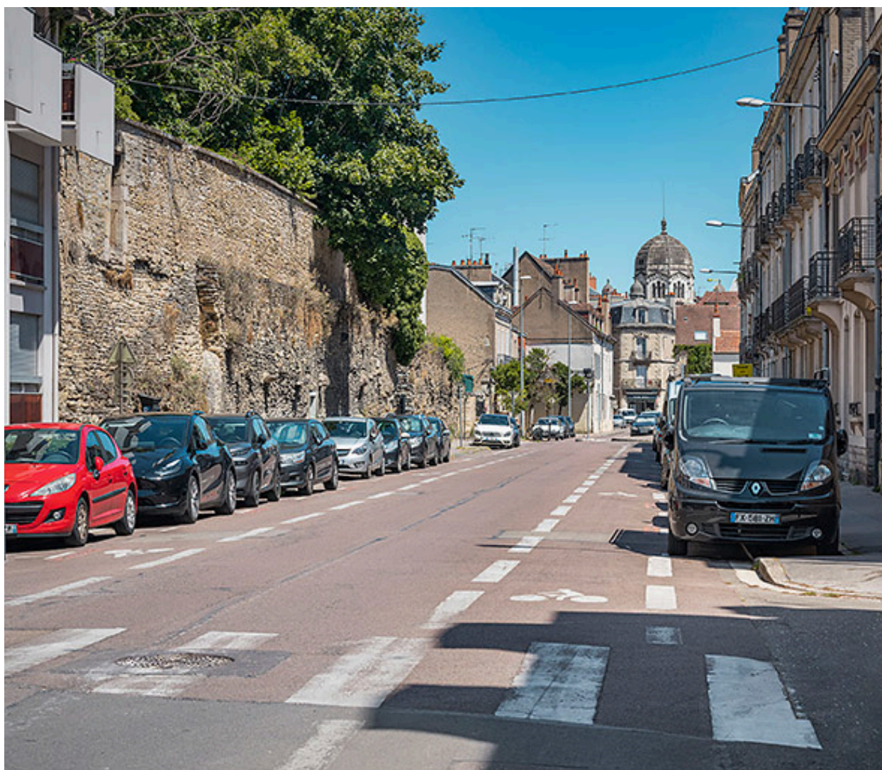
Vue de situation de la muraille, rue de Tivoli.
