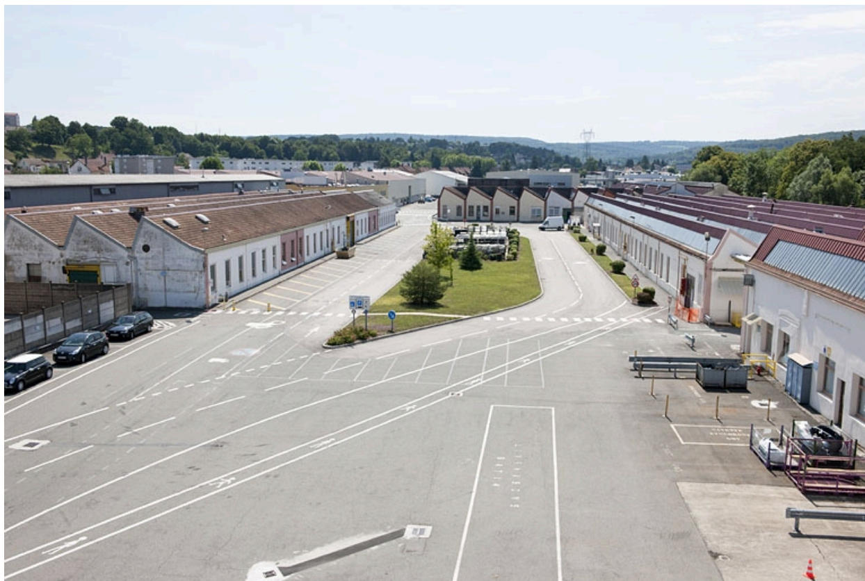
Automobile : usine de construction automobile de la Société Anonyme des Automobiles Peugeot dite usine des Autos, à Audincourt (88 rue de Seloncourt).
