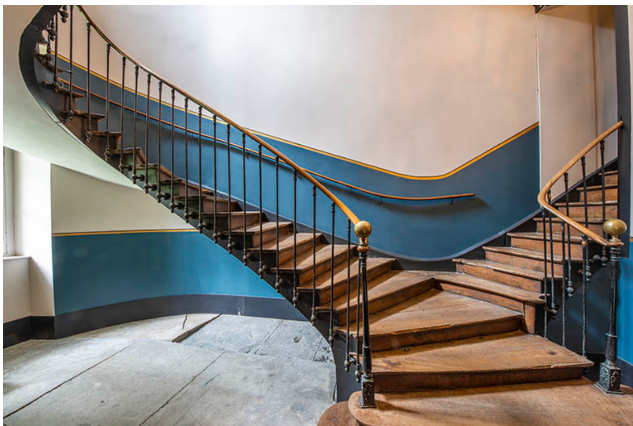
Première volée de l'escalier (aile nord).
