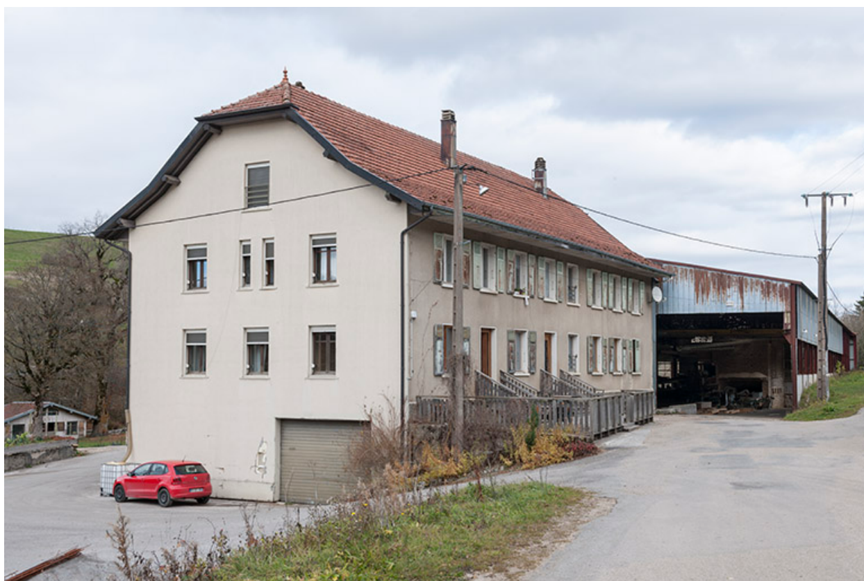
Bâtiment des logements et du bureau.
