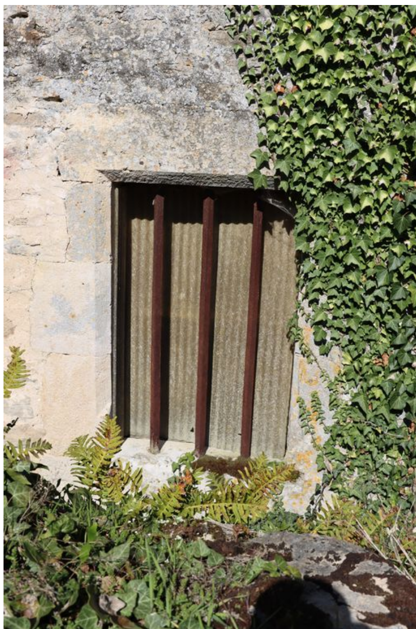
Détail d'une fenêtre de l'extension sud.
