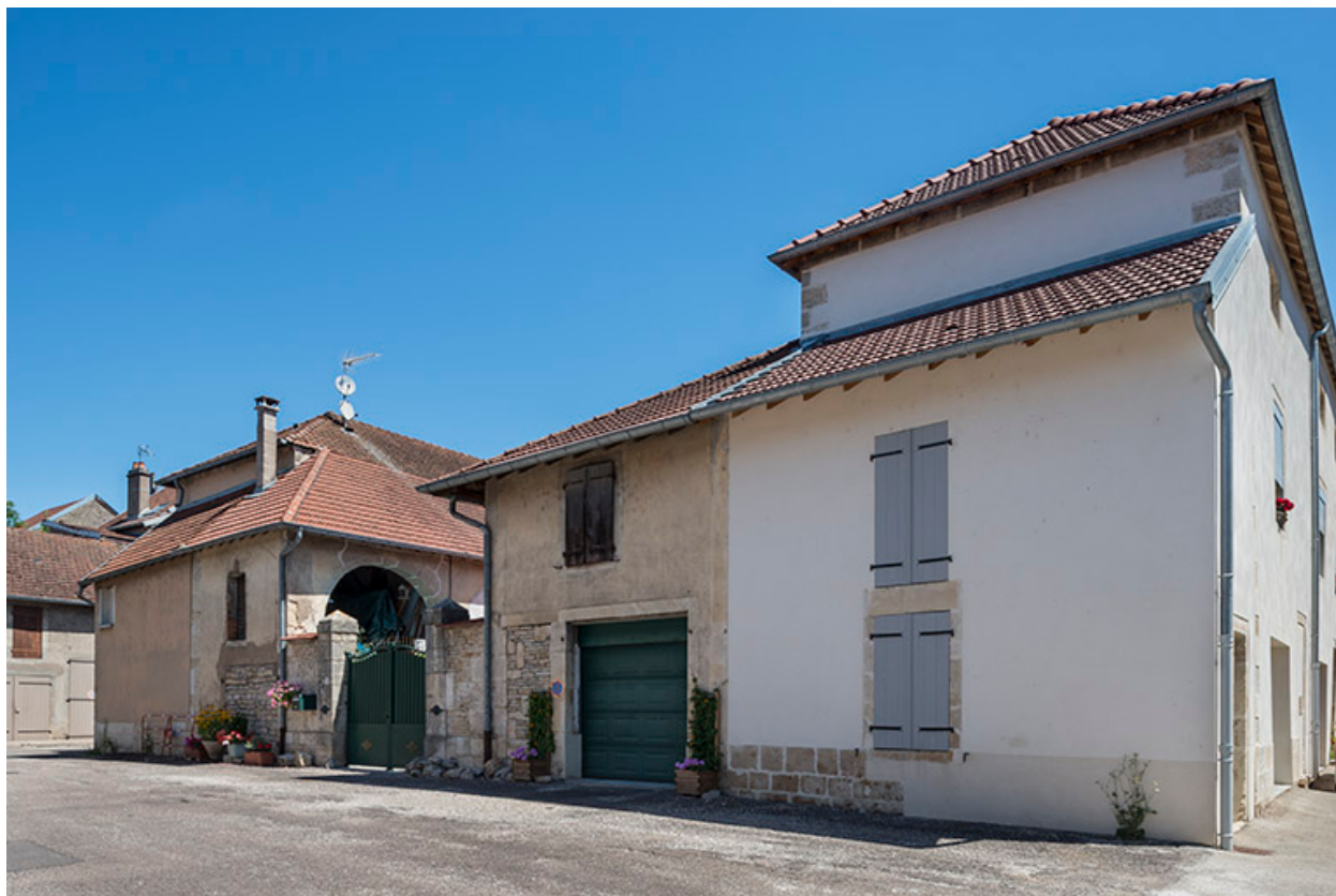
Élévation extérieure, vue depuis le sud-ouest.
