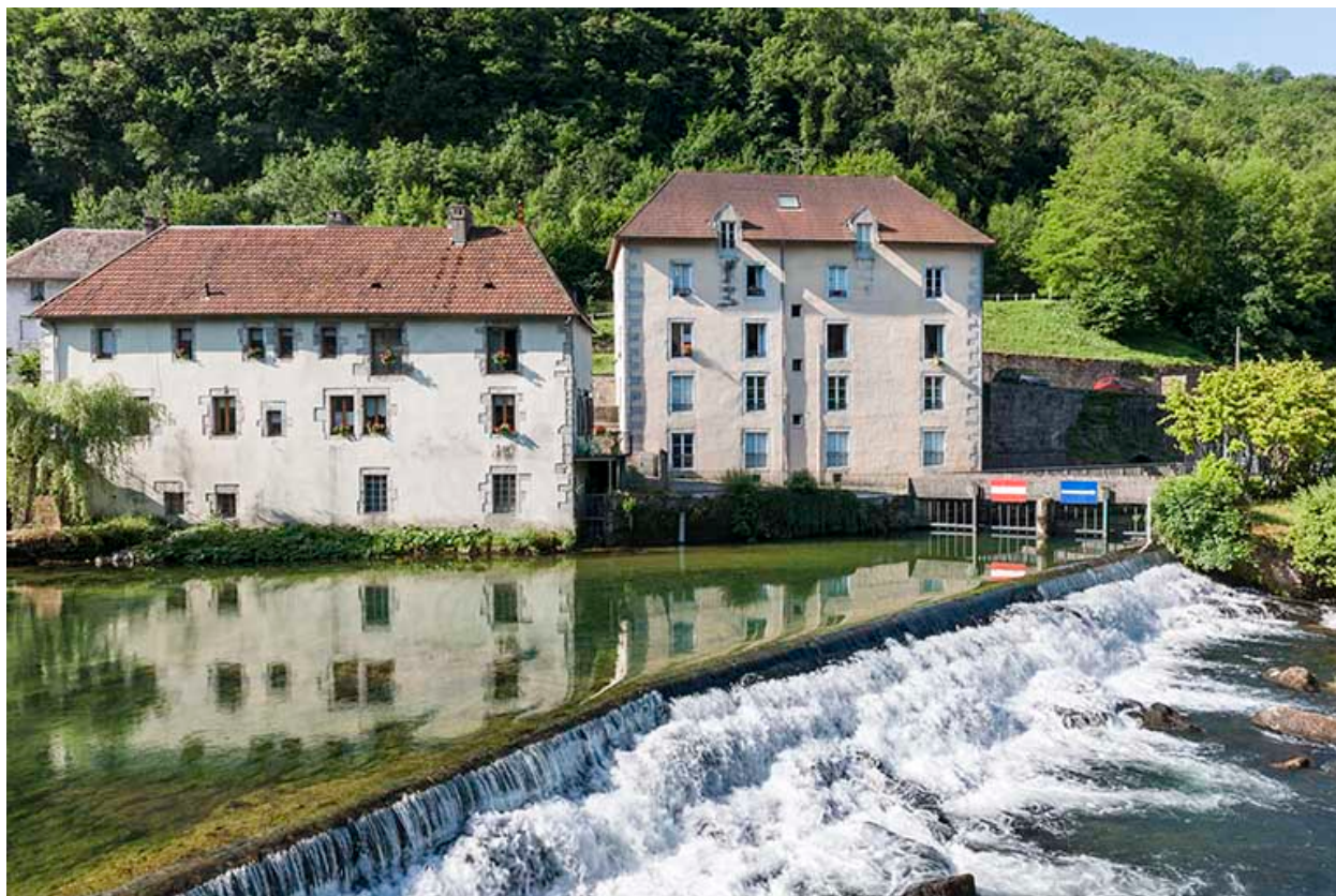
Façad nord des logements d'ouvriers.
