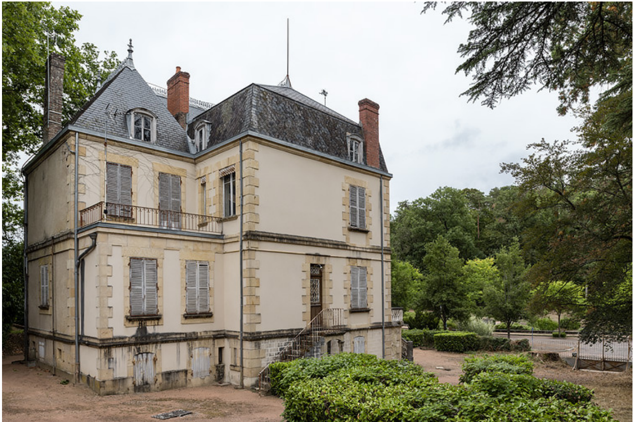
Élévation sud-ouest, vue depuis l'ouest.
